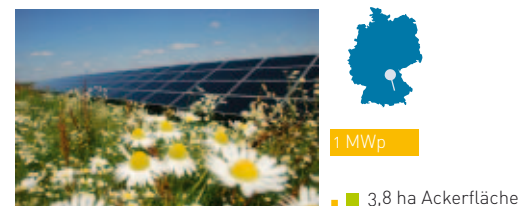
Solarpark Salmdorf Gehrlicher Solar AG, 2007 fertig gestellt
