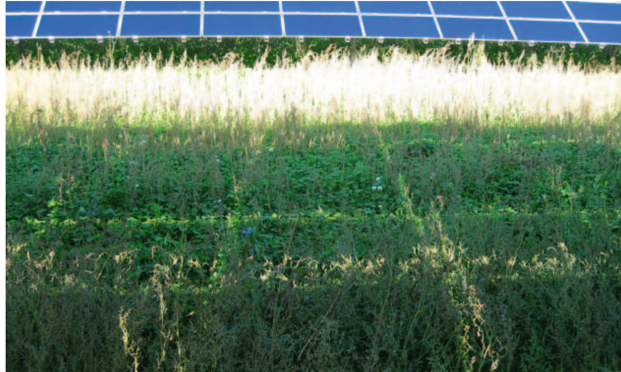
Auch unter den Modulen bildet sich üppige Vegetation. Lücken zwischen den Modulen ermöglichen einen gleichmäßigen Niederschlag. (Foto: Blitzstrom GmbH)
